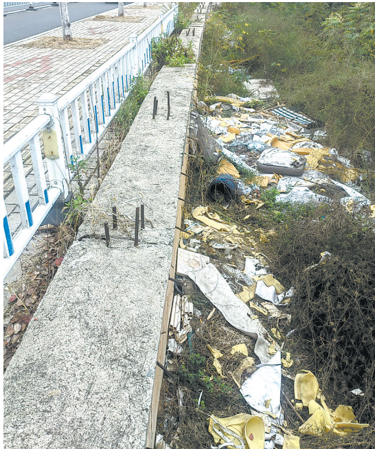
双江大道北侧路边被倒大量建筑垃圾。
