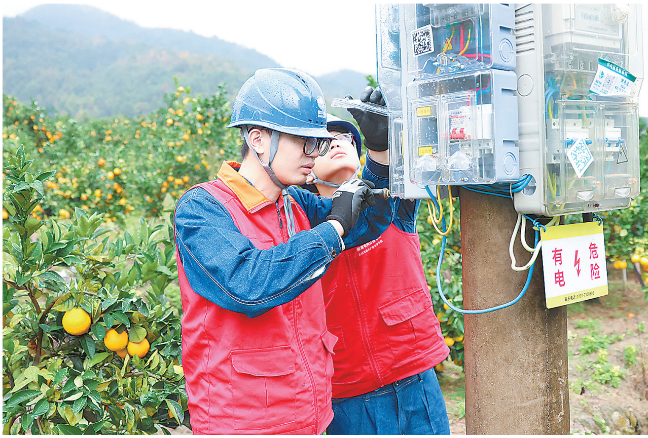
11月13日,国网宁都县供电公司组织先锋共产党员服务队在该县的会同乡百胜村,为村民义务检查线路设备,消除安全隐患,全力护航脐橙丰收季。温雪娇 赖雪玲 摄
