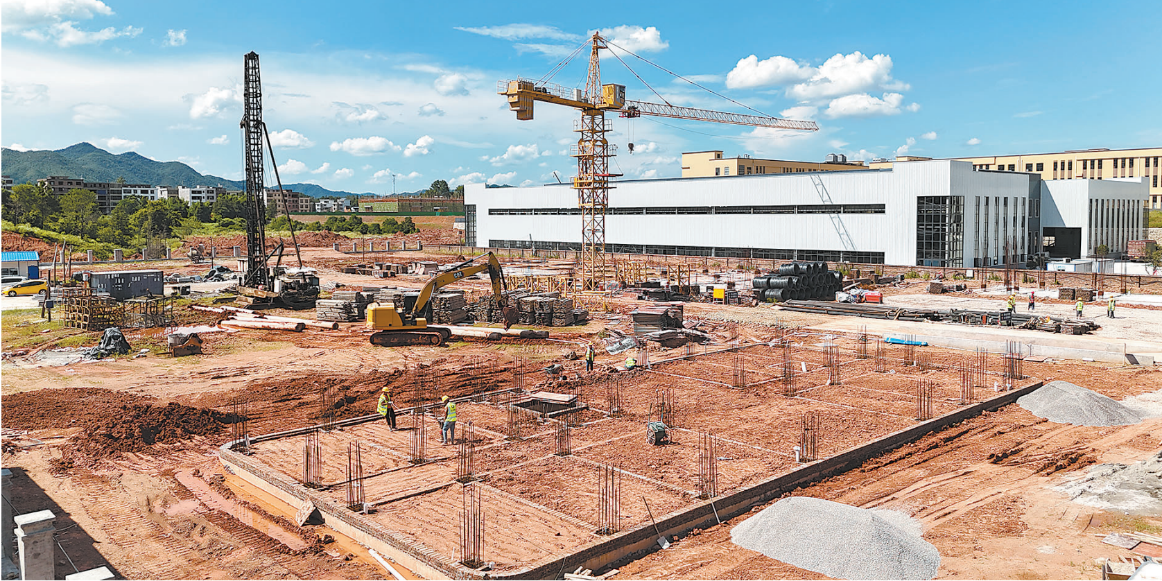
日前,在安远县展石工业园德诚半导体有限公司二期项目建设现场,工人们战高温、保安全,抢进度,确保项目如期推进。
