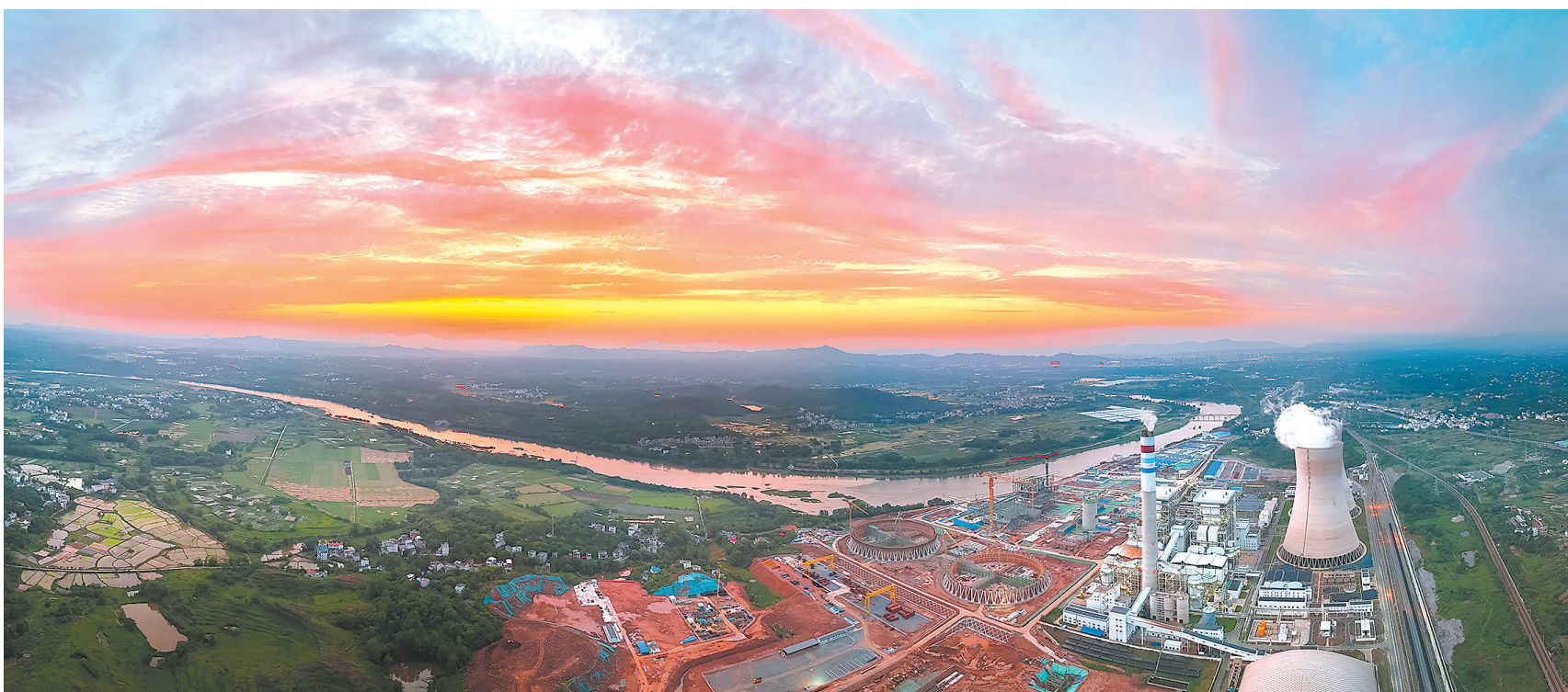
5月11日,信丰县大塘埠镇的陝投信丰能源2×1000MW机组扩建工程(信丰电厂二期项目)建设现场,塔吊林立,工人忙着设施建设。据了解,信丰电厂二期项目总投资约80亿元,是省重点建设项目和2024年“十百千万”示范引领项目。项目建成投产后,将极大提升赣南电力保供能力,为我市经济社会高质量发展提供坚强的能源支撑和保障。
