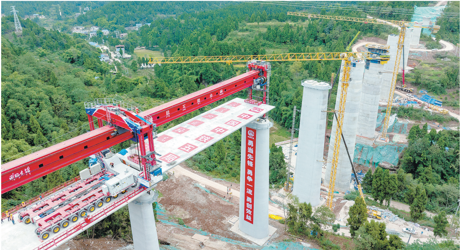
11月17日,中铁五局成渝中线高铁四川段项目部的架桥机将长40米、重千吨的箱梁架设在成渝中线高铁麻湾特大桥31-30号桥墩上。成渝中线高铁是我国“八纵八横”高铁网沿江通道的重要组成部分,正线全长292公里,设计时速350公里。 新华社记者江宏景摄
