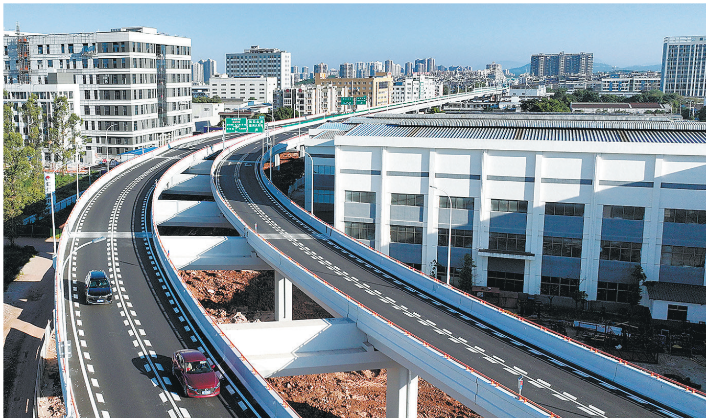
近日，记者拍摄的建设中的沙河大道快速路项目地面段。该项目由赣州发展集团筹资建设。主线高架桥已于8月27日建成通车。目前，正在加快建设地面段相关工程，电力管沟全部完成，排水工程完成30%，道路工程完成10%，项目预计年底全面竣工。
