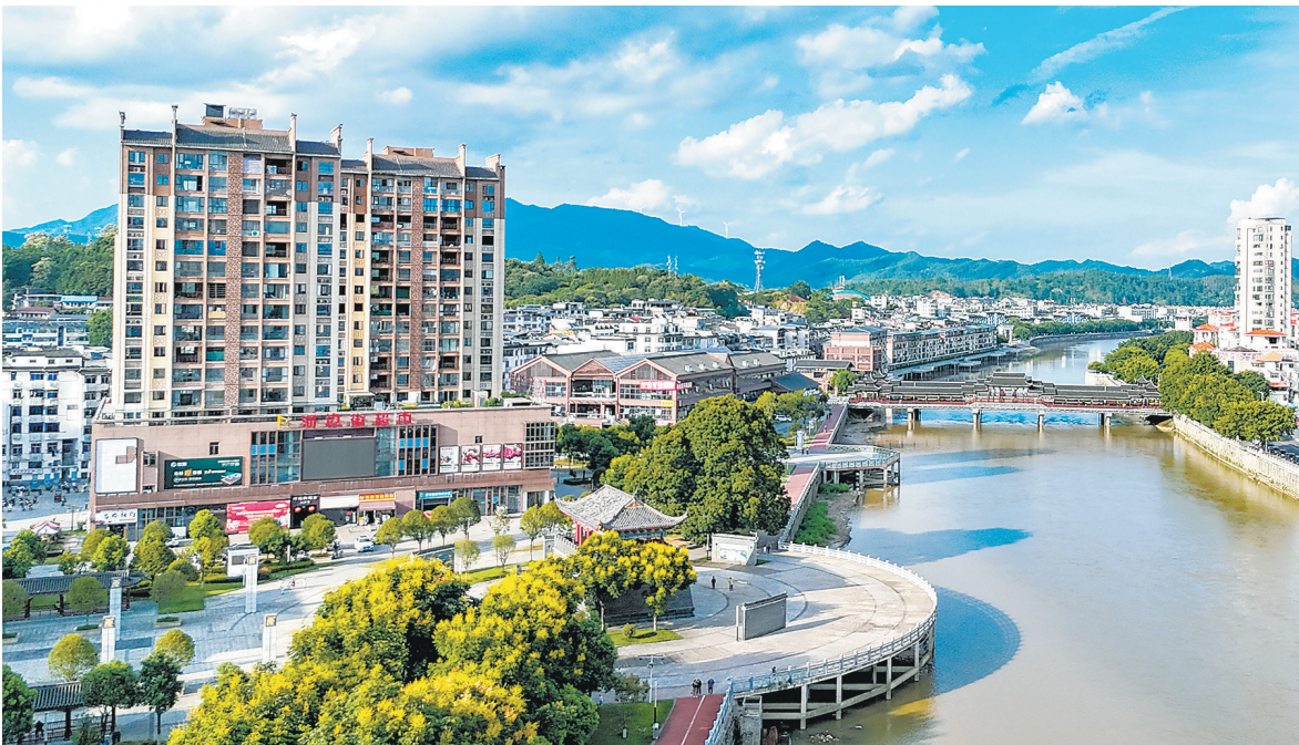
全南县城桃江北岸城市更新项目2023年底全部竣工后,新修建的河边街公园、新改造的解放桥与2020年开街的河边街串联在一起,成为桃江河畔的一道亮丽风景。
