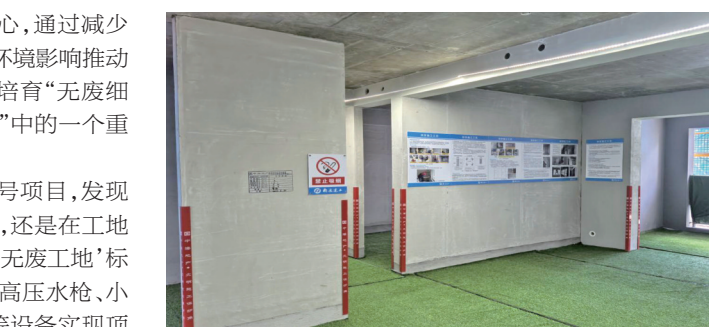
石膏砂浆施工工艺。
