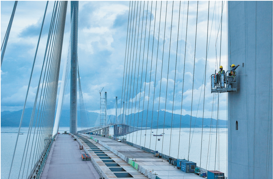
7月16日,中交路施工人员在黄茅海跨海通道高栏港大桥索塔进行涂装前清理(无人机照片)。每座索塔将进行六遍涂装。目前,中交路承建建的黄茅海跨海通道高栏港大桥已经进入索塔塔身涂装施工,被誉为海上“小蛮腰”的索塔单座涂装面积近万平方米。黄茅海跨海通道是粤港澳大湾区又一超大型跨海工程,连接珠海市和江门市,线路全长约31公里。跨海段由高栏港大桥和黄茅海大桥两座主桥组成,项目预计2024年年底通车。
