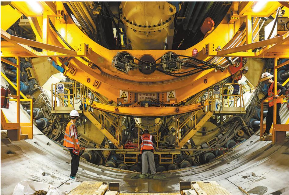
7月13日,施工人员在“鲲鹏号”盾构机内检查管片拼装精度。当日,中铁十一局承建的深江铁路深莞隧道西段“鲲鹏号”盾构机始发一个月掘进和隧道管片拼装突破百米。该段是13米级大直径单洞双线隧道,线路埋深跨度在9至62米。
