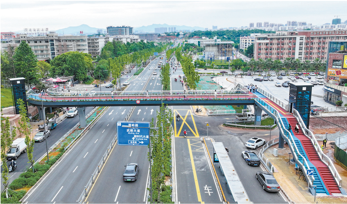
4月23日,赣州蓉江新区飞扬大道人行天桥正式投入使用。据悉,飞扬大道人行天桥是赣州蓉江新区的第六座人行桥,主桥长59米,桥梁净宽4米,主桥两端均配备了无障碍电梯。该人行天桥的建成,极大方便了赣南师范大学、江西应用技术职业学院等周边高校的师生通行。
